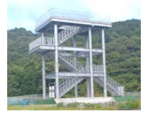
【H27再整備】3号塔(松崎)
