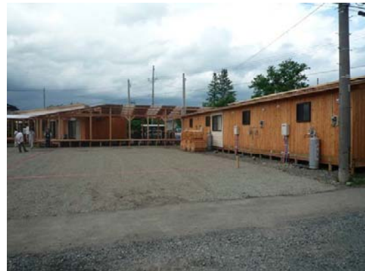
【岩手県東野市仮設住宅 岩手県建設業協会】
