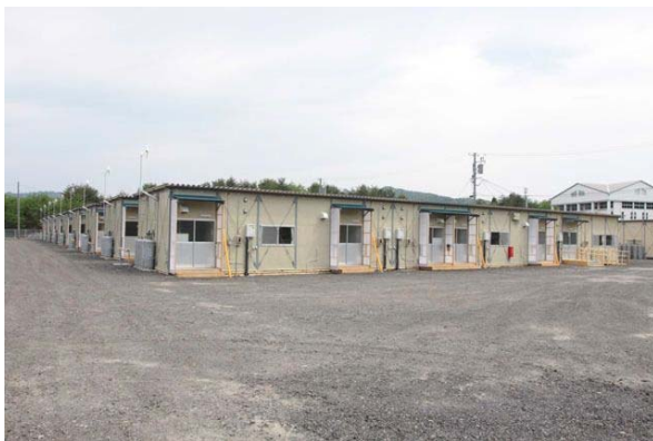
【岩手県山田町（仮設住宅）】
