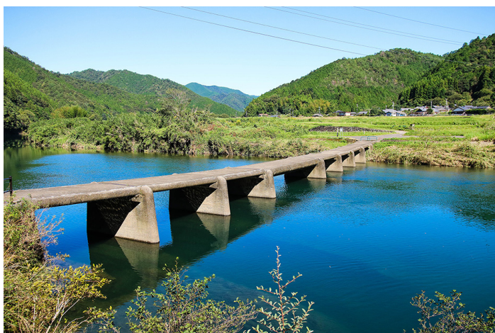
一斗俵沈下橋 (国指定文化財：登録有形文化財)
