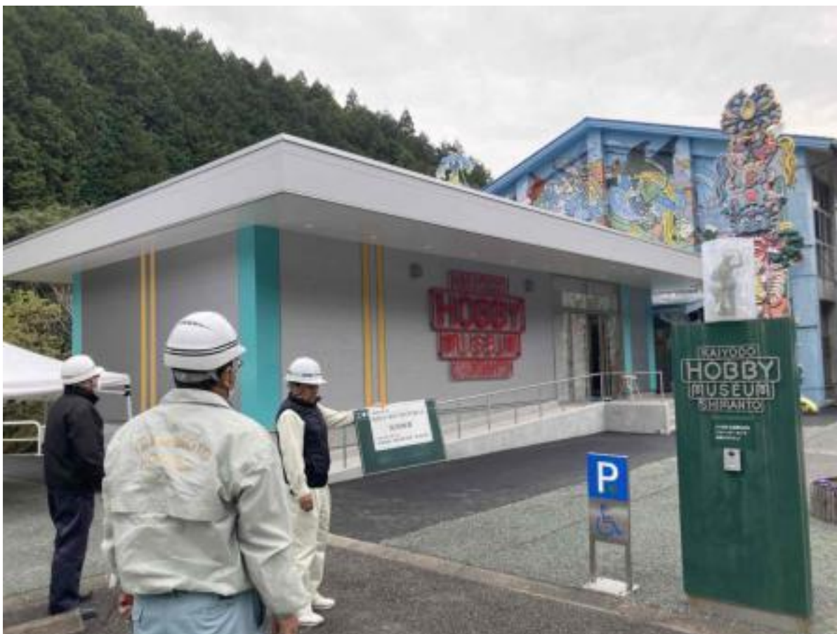
ホビー館改修写真（1階増築部分）
