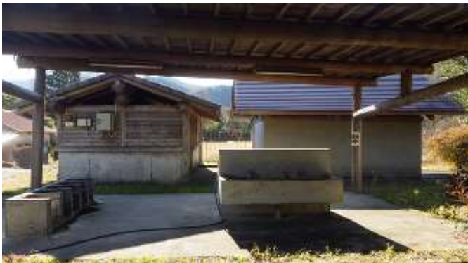
トイレ・シャワー・炊事棟
