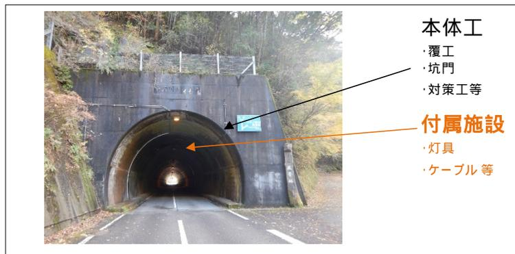
図-2 トンネル構造
