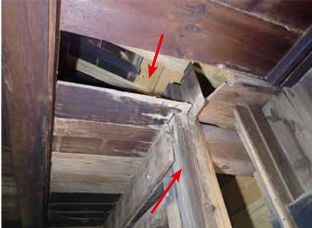
下の矢印は2階通し柱が残る。文化財指定後柱切断し、下屋の修理を行う(修理された野地板が白く映る)谷樋がうまくできなかったか、雨漏れの跡が柱に残っている。どちらが先かという点、東側増築と思われる。前に出した帳場の赤い印のある部分の襖の下張りにあった大福帳の日付が大正年間である。帳面は5年~6年は保管する為、付属屋2階増築年より先行して東側増築が実施されたと思われる。
