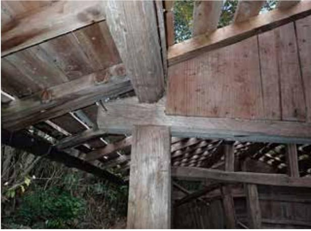
当初からの柱、梁、小屋組構造は折置組伝統工法となっている
