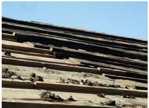
屋根野地板の入れ替えの際、瓦は再利用しており、屋根野地板だけの入替となっている。
