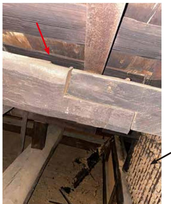
赤い矢印は隅木の痕跡。黒の矢印は増築の際、当初建東端部の屋根裏を土壁塗りとしている。これは増築部が全て土間で釜屋の機能を持っていた為である。
