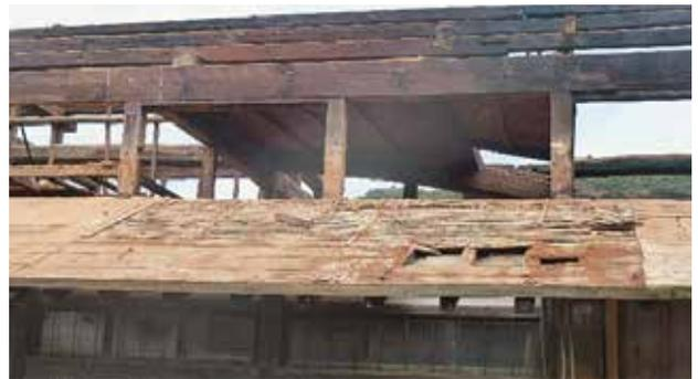
主屋屋根瓦・下地撤去・下屋が残る
