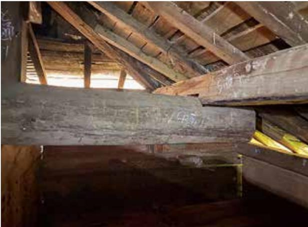
西面入母屋付近、北隅部、屋根裏が板野地になっている部分は補修した後。
