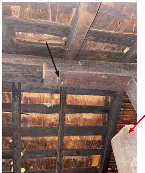
赤の矢印は当初建築の竹野地板である。黒の矢印はウシ梁と東増築の際の腰掛仕口。ここにも入母屋の壁痕跡がある。このことから、入母屋妻面は土壁でなく、板壁であり、壁より梁小口を出す工法であったことが分かる。
