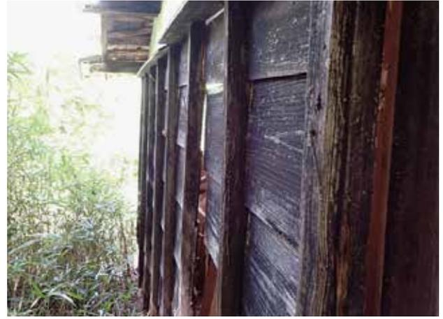
南面外壁、押縁付下見板張り、防腐処理マス4と5の間の軸組土台立ちの柱足元は防腐塗装がみえる
