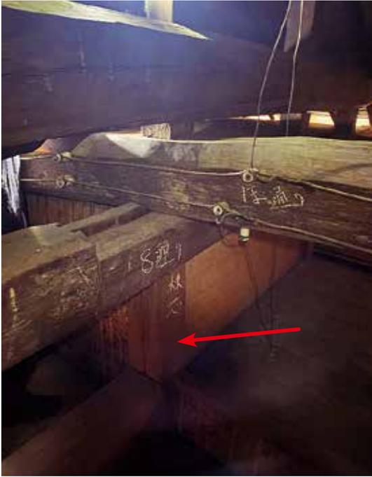
大国柱屋根裏。東西方向、南北方向ともに多段組となっている。
