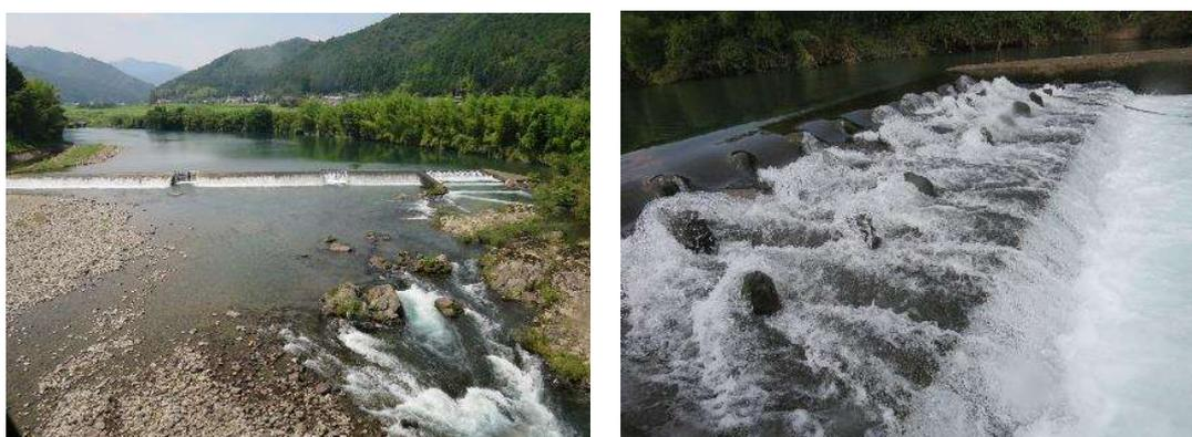
図 1-4 越行堰と左岸側仁尾建設された魚道(左)。魚道呑口付近の流況(右)
