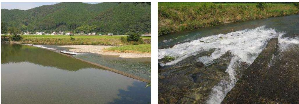
図1-2 大井野堰(左)と植石が失われ機能をほぼ失った粗石付き斜路式魚道
