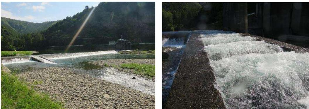
図1-3 三堰(左)。右岸側の魚道は植石が失われ機能をほぼ失った状態。左岸側の階段式魚道は下流に突出しており、かつ、通水量が過剰で乱流となっている(右)
