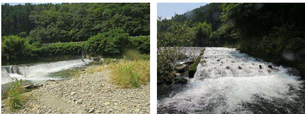
図 1-5 秋丸堰(左)。左岸側の魚道は下流に突出しており、かつ、通水量が過剰で乱流が発生(右)
