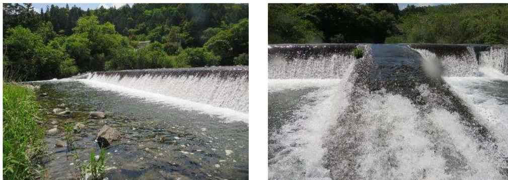
図 1-6 日野地橋上流の堰堤(左)。魚道は植石が無くなり、機能を完全に失った状態。
